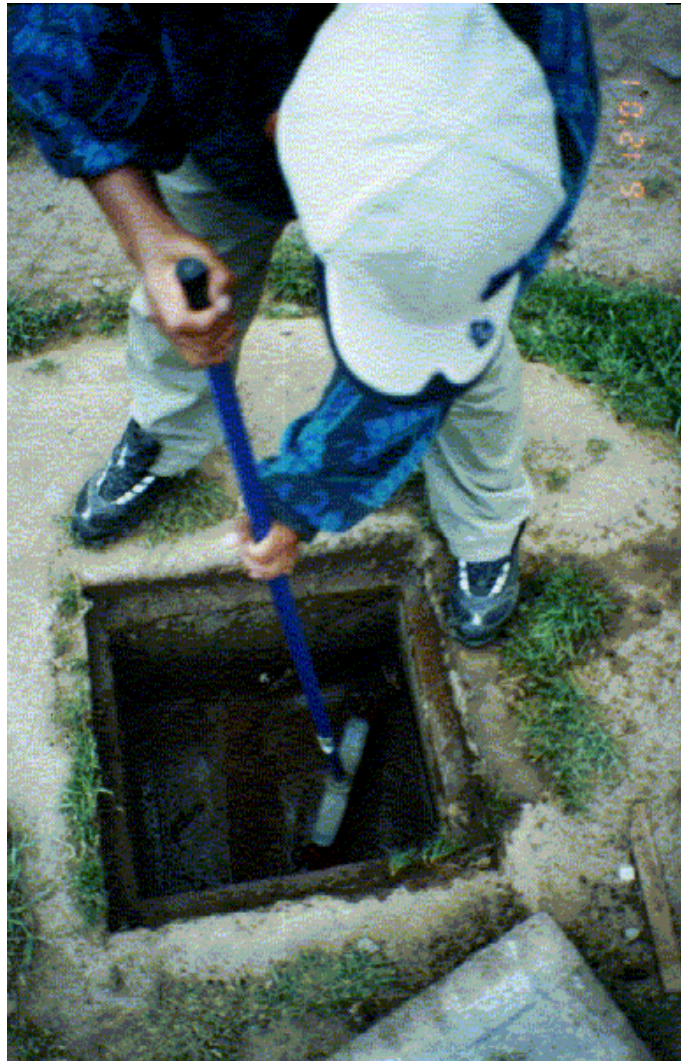
Mantenimiento de cámara desengrasadora Huayna Potosí (Foto propia)
