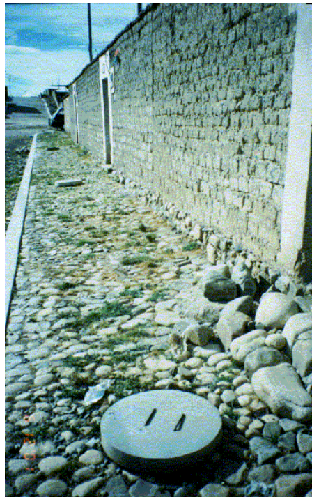
Cámaras en acera San Juan de Río Seco (Foto propia)
