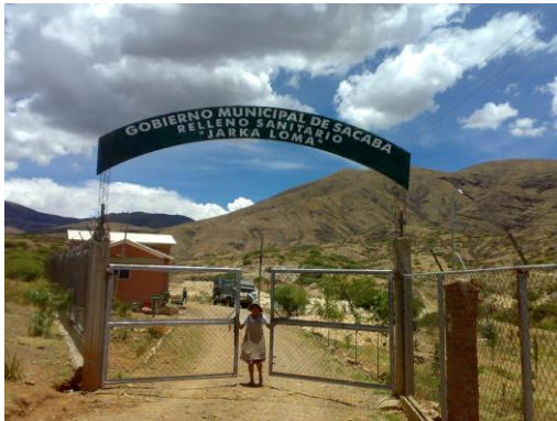
Ingreso a Relleno Sanitario
