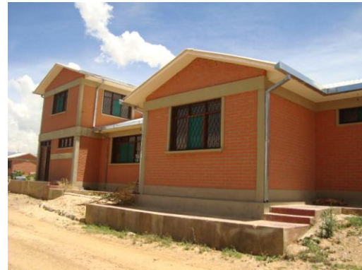
Área administrativa y técnica
