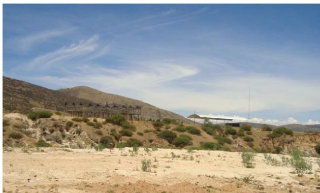
Sacaba, Vista general Planta de Aprovechamiento
