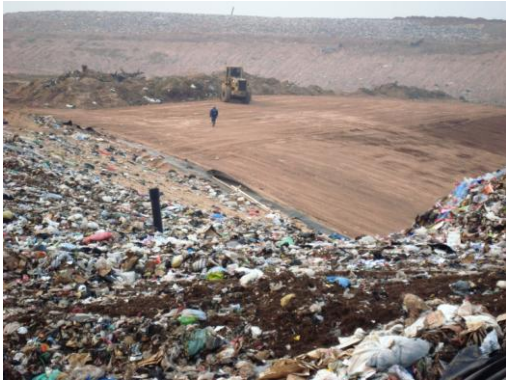
Compactado de base de celda
