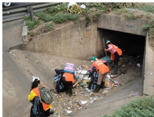
Santa Cruz de la Sierra, limpieza de canales
