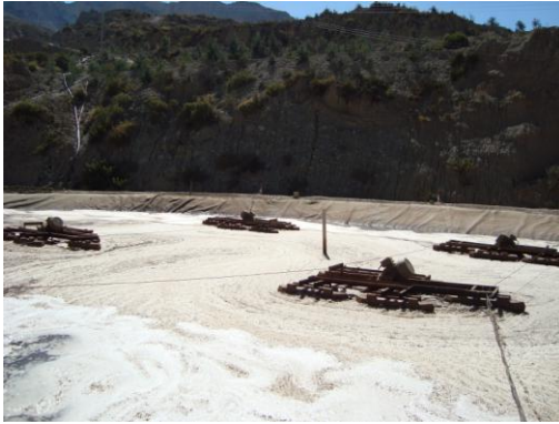
Piscina de de Lixiviados, tratamiento aerobico
