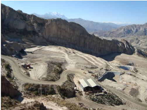
Vista general del Relleno Sanitario de Mallasa
