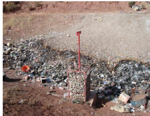
Capatadores de Biogás
