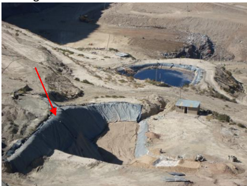
Celda para disposición de RES
