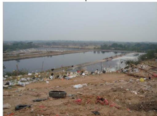
Piscinas de tratamiento de Lixiviados
