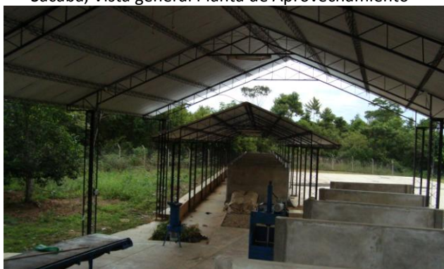
Ivirgarzama, Planta de Aprovechamiento
