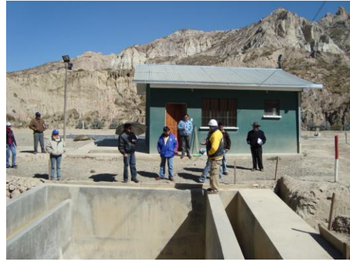
Piscina para tratamiento de Lodos
