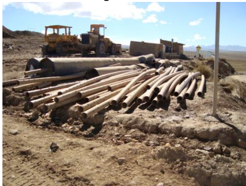
Tuberías de PVC para lixiviados
