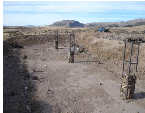
Capatadores de Biogás
