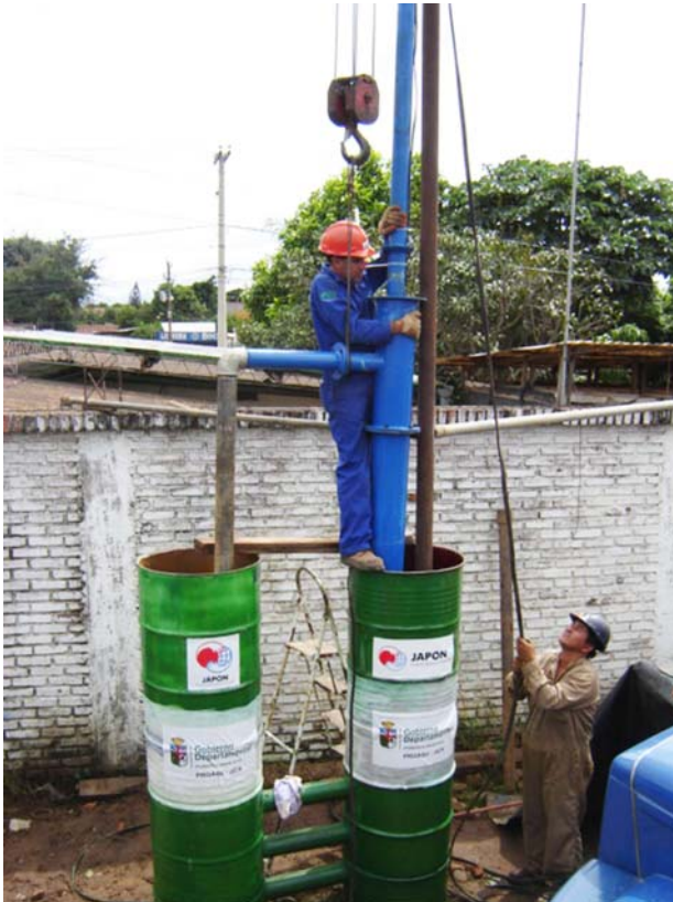
Fig.29 Esquema de bomba sumergible sin Tubería de impulsión.
