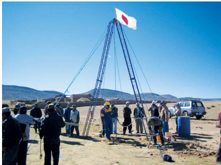
Equipo de Perforación Manual, La Paz 2007.
