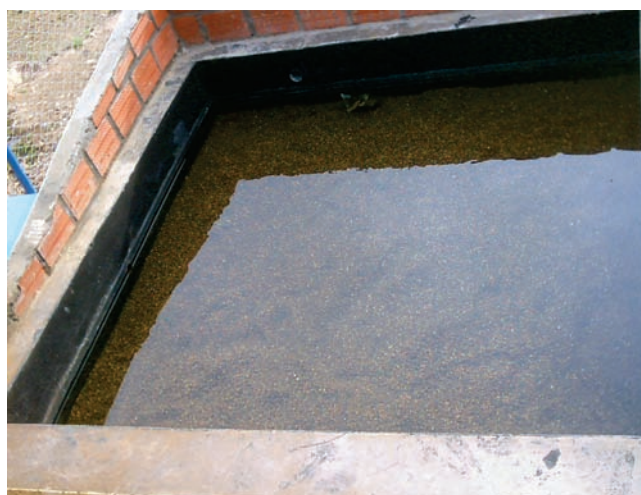
Foto 1. 2 Filtro de grava de flujo ascendente
