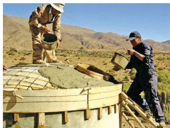
Foto 1.6. Vaciado de tapa
