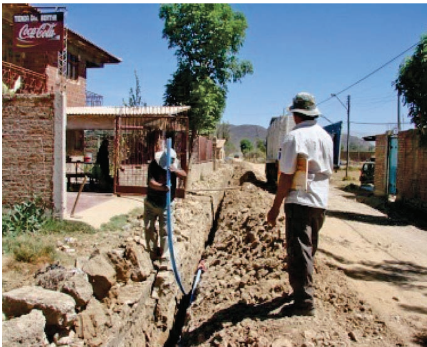
Foto 2.4 Tendido de tubería la Maica - C. Cochabamba
