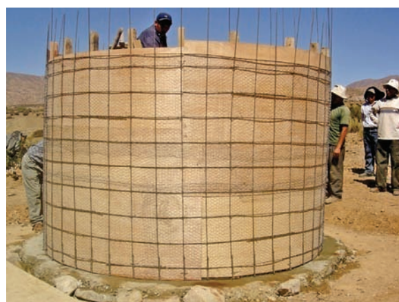
Foto 1.4. Encofrado interior
