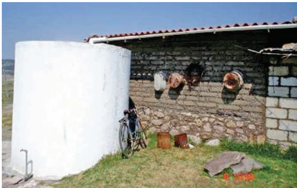
Foto 1.3 Tanque sobre el piso
