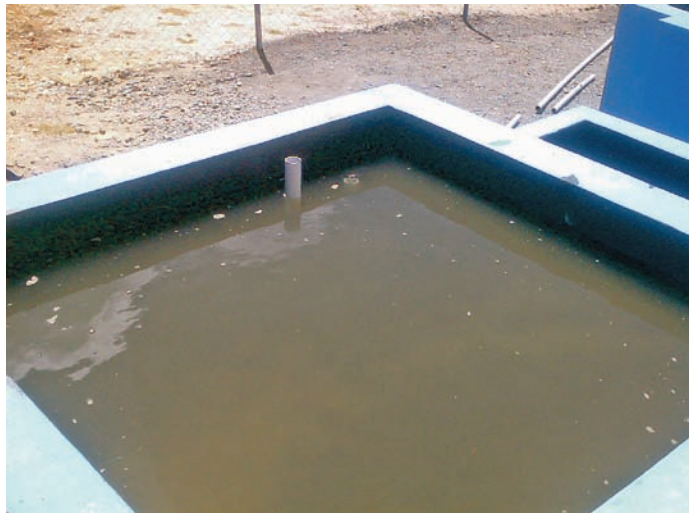
Foto 3. 2 Filtro grueso Ascendente en capas, Loc. Cachilipe Municipio Achacachi
