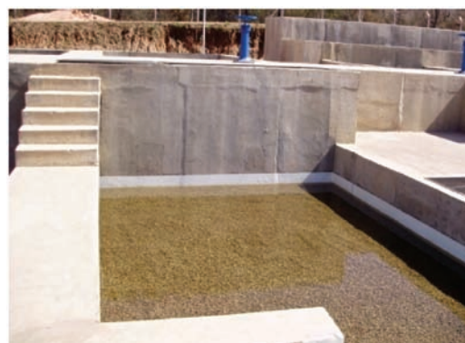
Filtro Grueso Ascendente Loc. Villamontes
