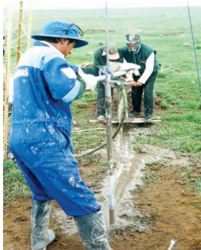
Foto 1.3 Proceso de perforación
