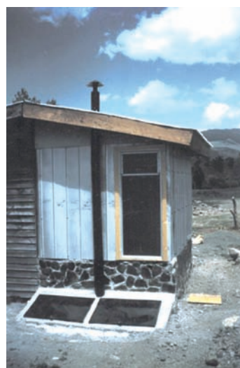
Fig. 2.10 Baño con panel solar domiciliario
