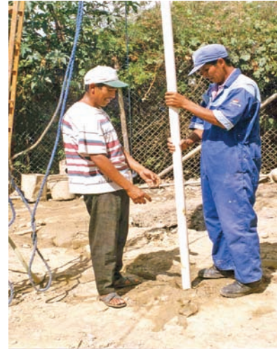
Foto 1.4. Encamizado del pozo
