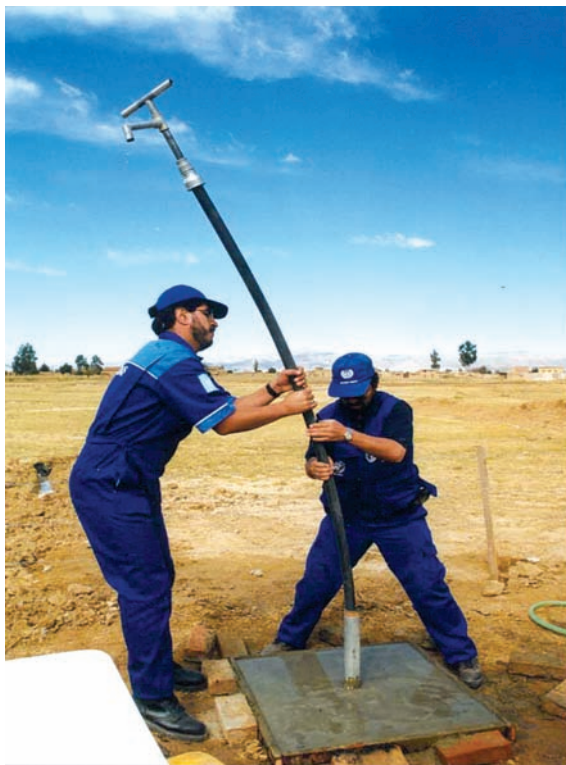
Foto 1.1 Colocación de la bomba
