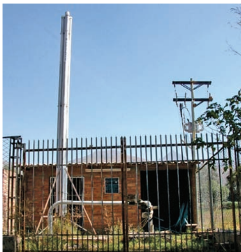
Foto 3. Torre Hidroneumática Clásica
