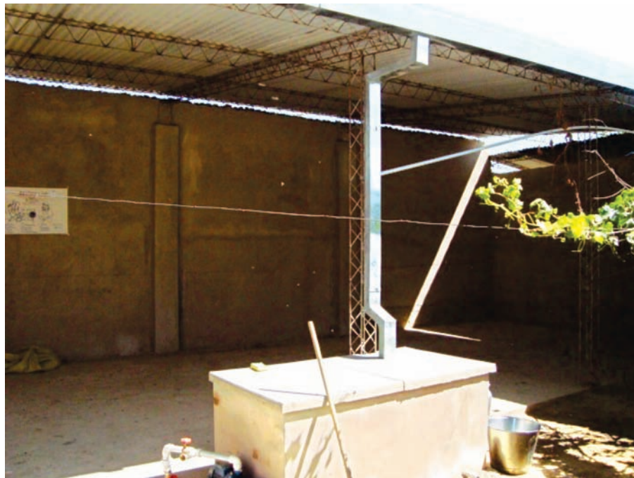
Foto 1.1 Bajante e interceptor Localidad: Ciudad de Cochabamba
