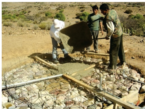
Foto1.1 Vaciado de losa de fondo
