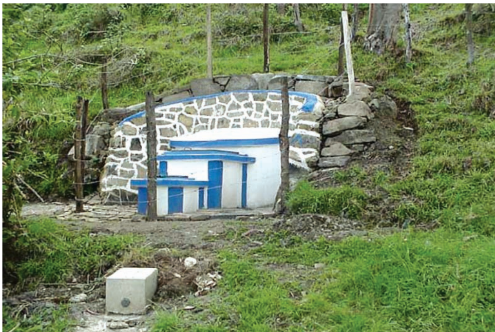
Foto1.1 Captación de ladera y primer cerco
