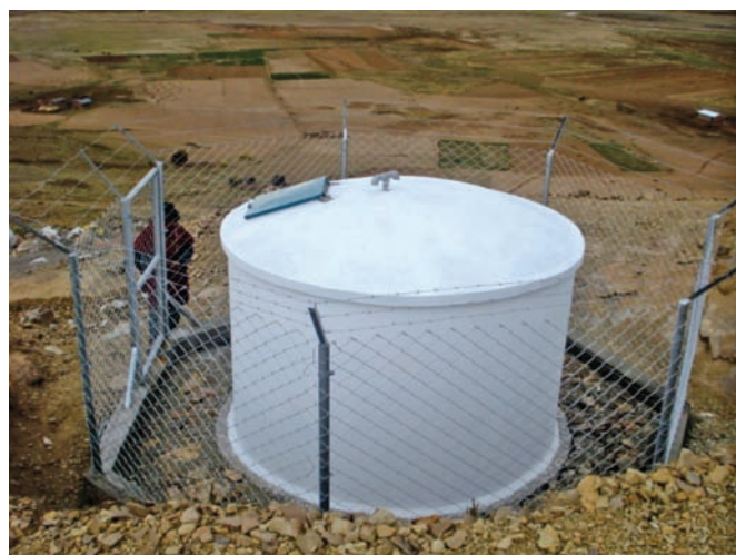
Foto1.8. Acabado con cerco perimetral
