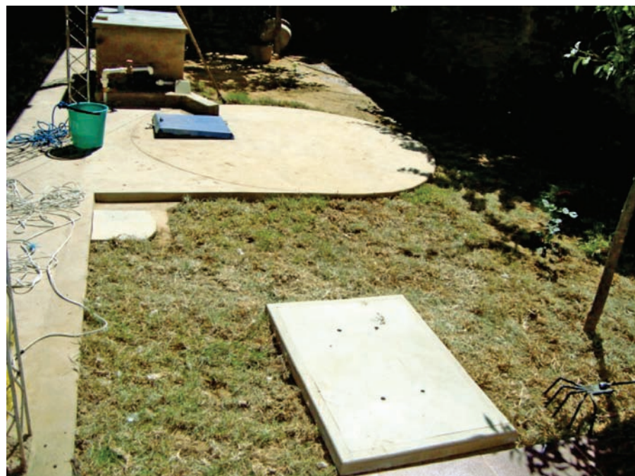
Foto 1.2 Tanque enterrado Localidad: Ciudad de Cochabamba
