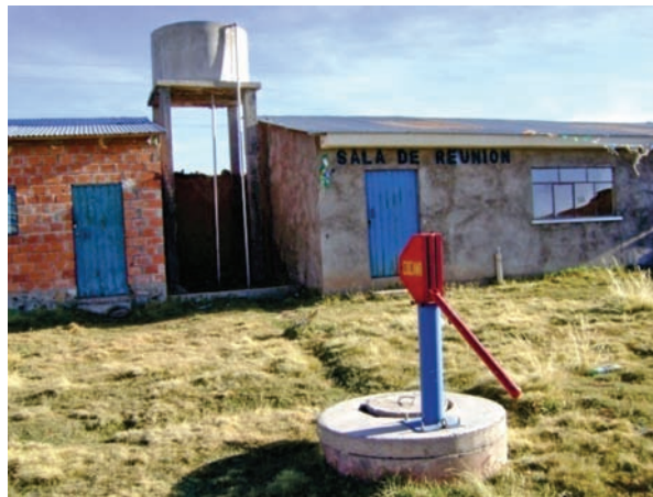
Foto 2.2. Bomba Wara de elevación Comunidad: Tambillo-módulo lechero
