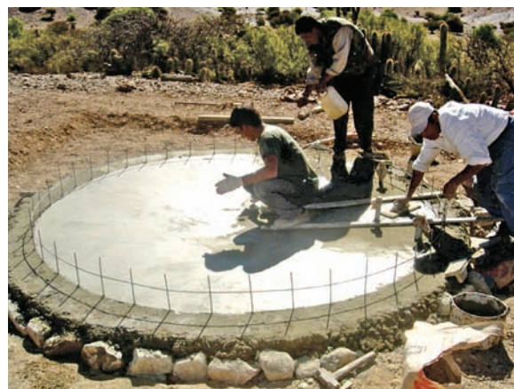
Foto 1.2 Concluida la losa de fondo
