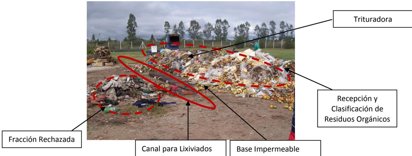
**6.5.2.3. Composición de la Mezcla de Residuos a Compostar:** Durante la preparación de la mezcla a composta se pierde humedad en los residuos orgánicos, esta pérdida de humedad será por la evapotranspiración y la generación de lixiviado por lo que esta actividad tendrá que ser realizada en un área con base impermeabilizada y con sistema de recolección de lixiviado.
