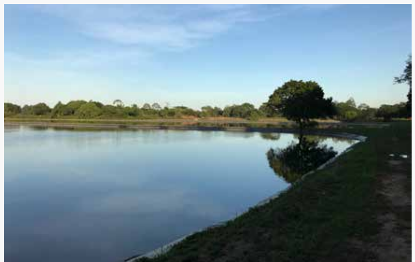
Foto: Laguna de maduración de la PTAR de COSMOL (Montero - Santa Cruz) © AAPS.
