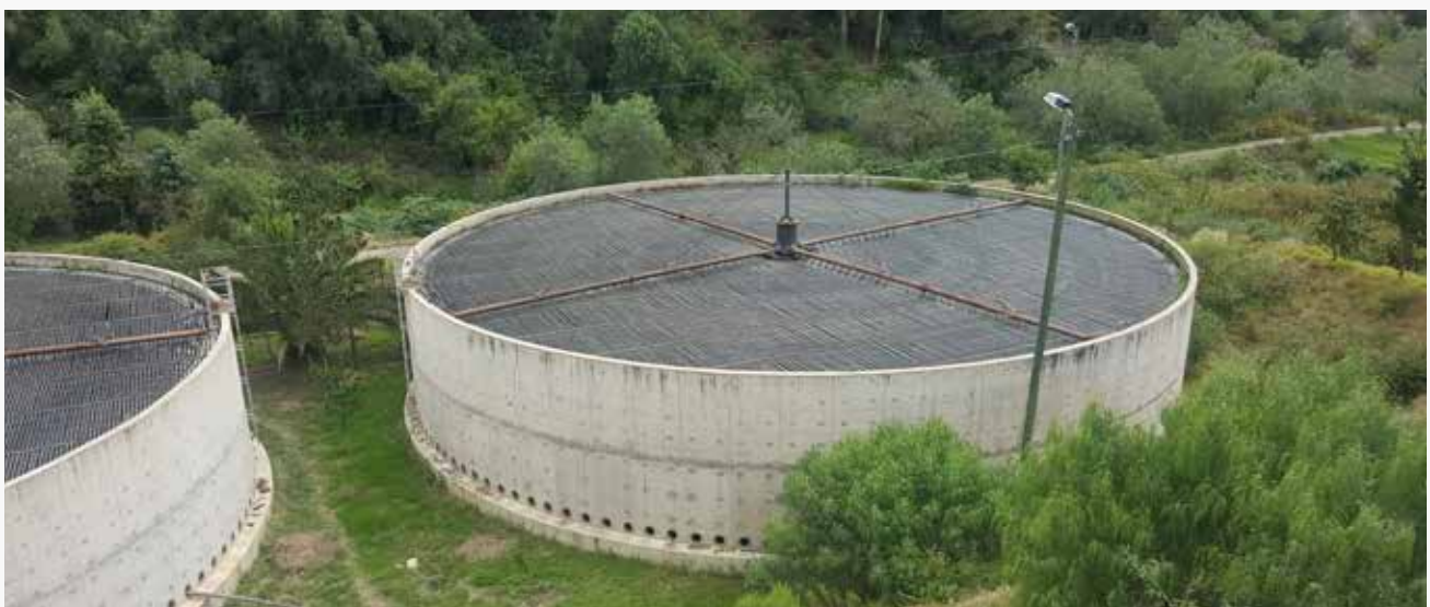
Foto: Filtro percolador de ELAPAS (Sucre) © AAPS.
