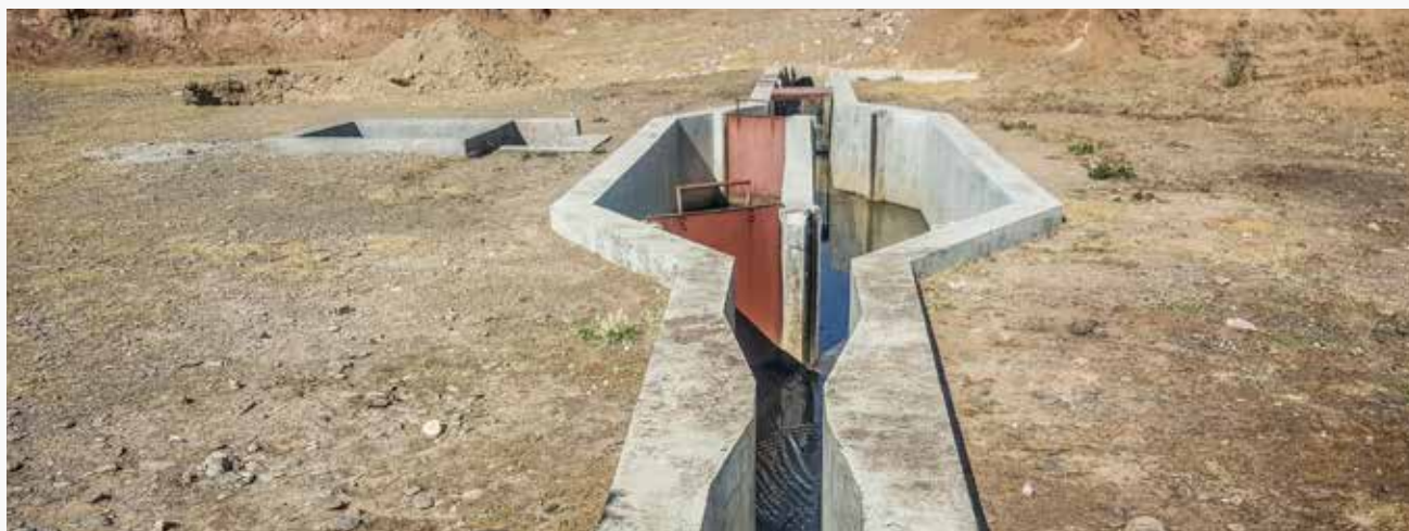
Foto: Pretratamiento y desarenadores de EMSABAV (Villazón - Potosí) © AAPS.
