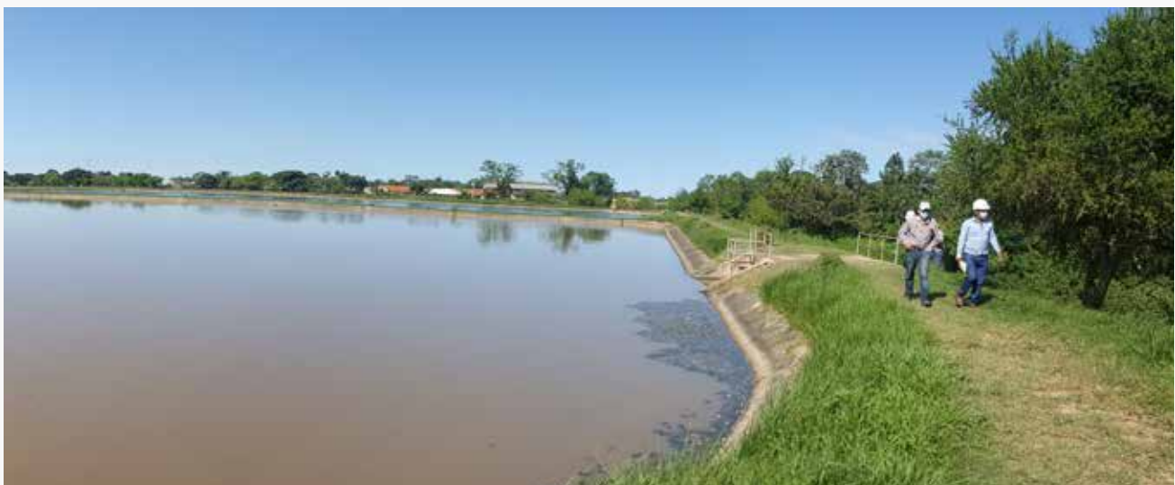
Foto: Laguna facultativa de la PTAR de COATRI (Trinidad) © AAPS.
