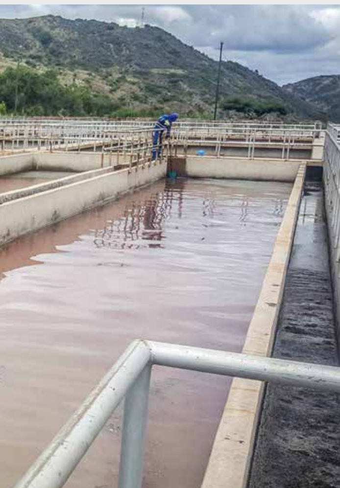
Foto: Tanques Imhoff de la PTAR de ELAPAS (Sucre) © AAPS.
