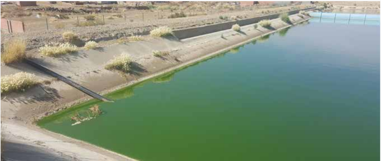
Foto: Laguna de estabilización de la PTAR de EMSABAV (Villazón - Potosí) © AAPS.
