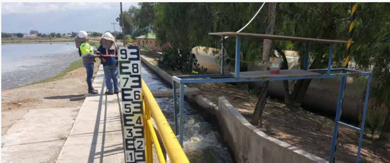
Foto: Medidor de caudal y canal de distribución de la PTAR Albarrancho (SEMAPA - Cochabamba) © AAPS.
