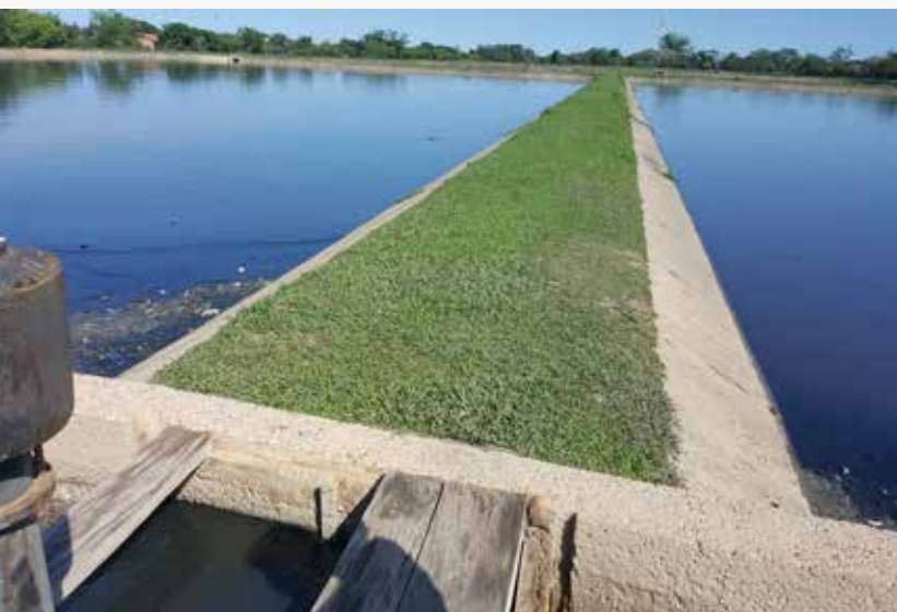
Foto: Lagunas anaerobias de la PTAR de COATRI (Trinidad) © AAPS.
