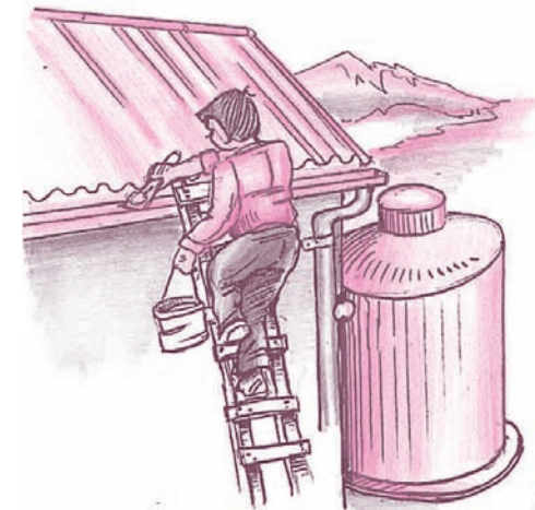
Limpieza del techo y canaleta
