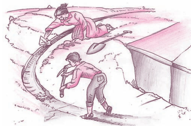
Limpieza de la zanja de coronamiento, de hierbas
