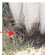
Paredes bien mantenidas pero con cimentación de columnas en contacto con el suelo, lo que produce su oxidación. La hierba esconde las zonas oxidadas.
