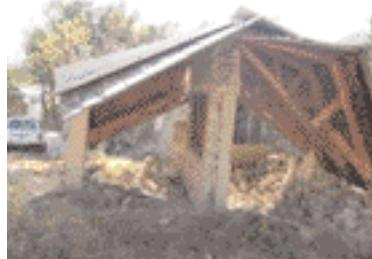
*Los agrietamientos o rompimientos* de los elementos de madera son una clara evidencia de falta de resistencia del elemento y es necesaria la participación de un técnico que permita adoptar las medidas adecuadas de protección para el establecimiento de salud.
