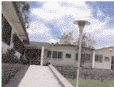
Dispensario médico. Estructura metálica con paredes de bloque de hormigón, cubierta ligera, de un piso.
