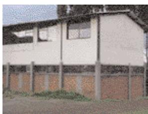
Estructura metálica originalmente de un piso, con losa nueva de entrepiso y posible efecto de columna corta ante sismo.
