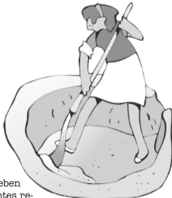
EXCAVACIÓN DEL POZO PARA LA LETRINA
