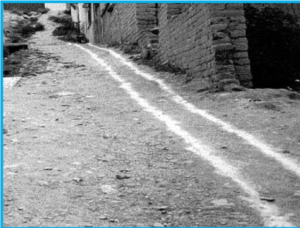
Es el trazado en terreno del elemento que se quiere construir, donde se ubican con exactitud las tuberías, las cámaras, teniendo cuidado del sentido del flujo, se apoyará siempre una fácil evacuación de los caudales. En ningún caso debe generar contra flujos. (no debe ir en sentido contrario).
