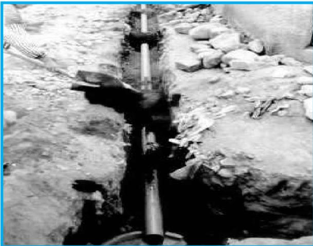
Es el movimiento de tierras que se genera para incorporar las tuberías ya sea de agua potable o de alcantarillado sanitario.
