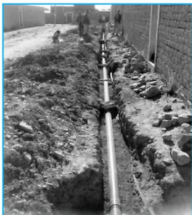
*Durante el proceso de colocado de tuberías PVC cuidar la pendiente porque estos sistemas siempre funcionan por gravedad, cualquier alteración modifica el comportamiento hidráulico (contra flujo de caudales, estancamiento, mal funcionamiento). La fotografía muestra la importancia de colocar elementos de fijación cada 2 o 3m. Esto ayudará a que las tuberías no se deformen durante el proceso de rellenado.*
