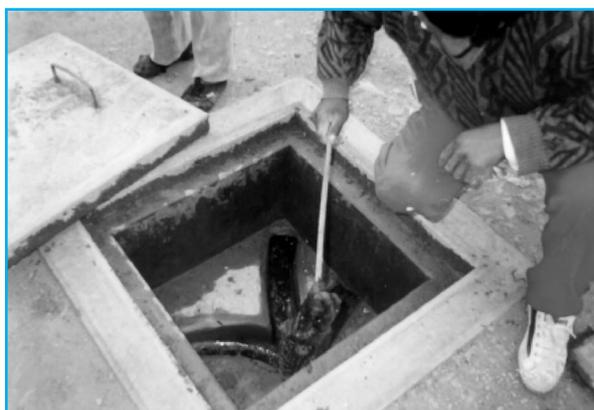
*La fotografía muestra el funcionamiento de un sistema de alcantarillado sanitario y se refiere a la medición de la altura del agua que fluye por la cámara (el flujo debe ser constante).*
