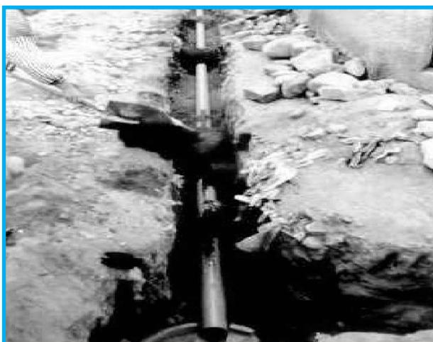
Es el movimiento de tierras que se genera para incorporar las tuberías ya sea de agua potable o de alcantarillado sanitario. Es importante en estos casos que se controle la profundidad de las excavaciones que deben estar acorde con las pendientes de proyecto. Casi en la mayoría de los casos las excavaciones son manuales. La tierra extraída por la excavación debe colocarse en un solo lado y su distancia mínima debe ser 0.80 m. Esto facilita el trabajo de colocación de la tubería.
