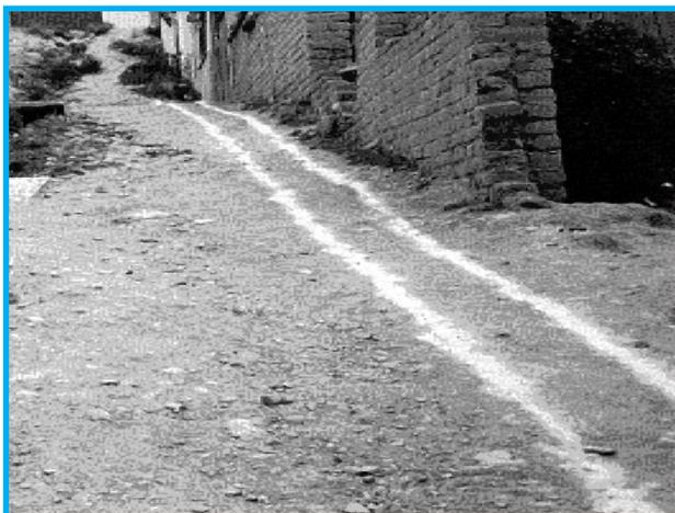
Es el trazado en terreno del elemento que se quiere construir, donde se ubican con exactitud las tuberías, las cámaras, teniendo cuidado el sentido del flujo, debe permitir siempre una fácil evacuación de los caudales pero en ningún caso debe generarse contra flujos (no debe ir en sentido contrario).
