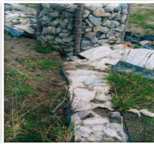
Figura 5.4: Reemplazó del Geotextil o Tela de Ingeniería
