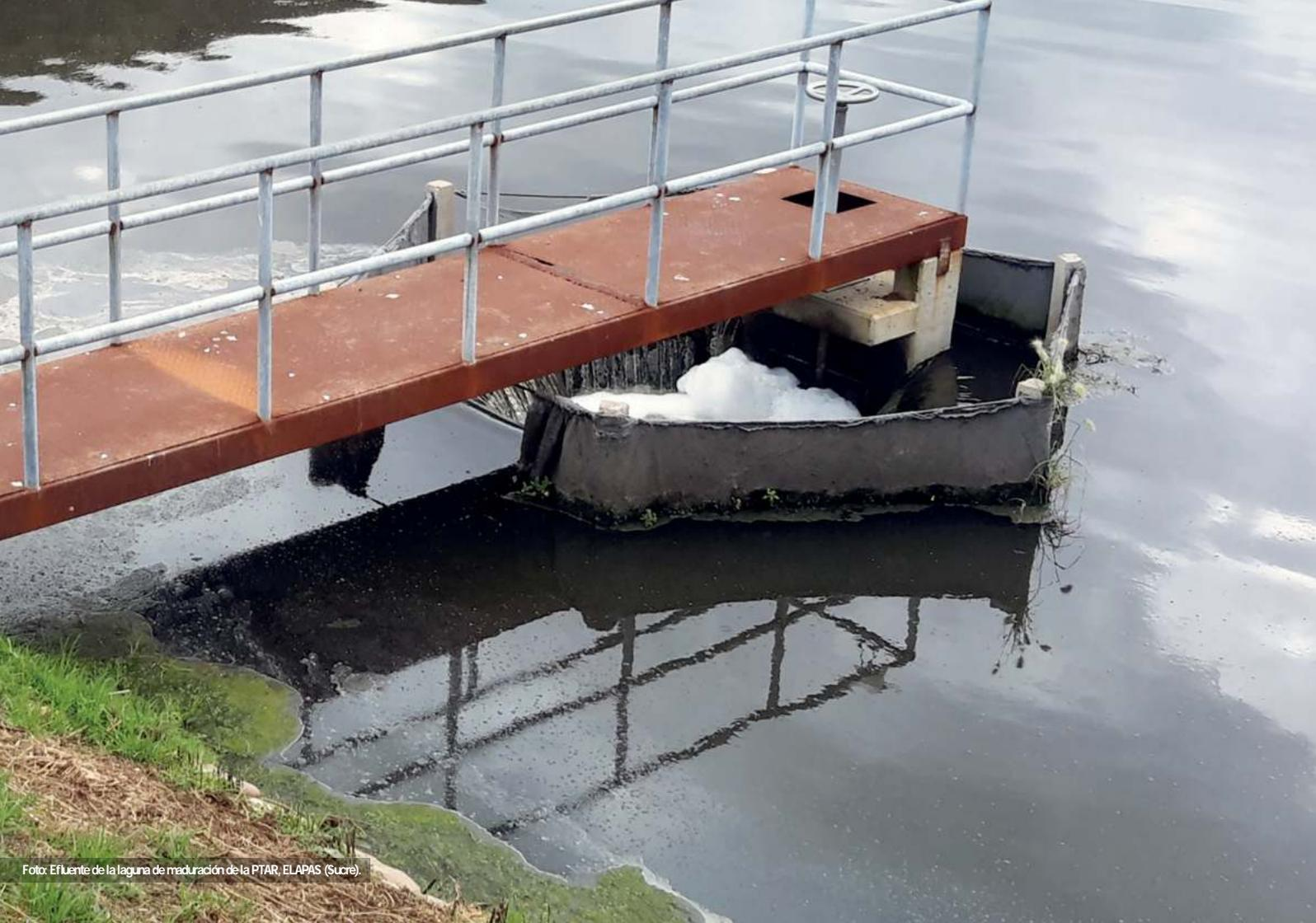
Foto: Efluente de la laguna de maduración de la PTAR, ELAPAS (Sucre).
