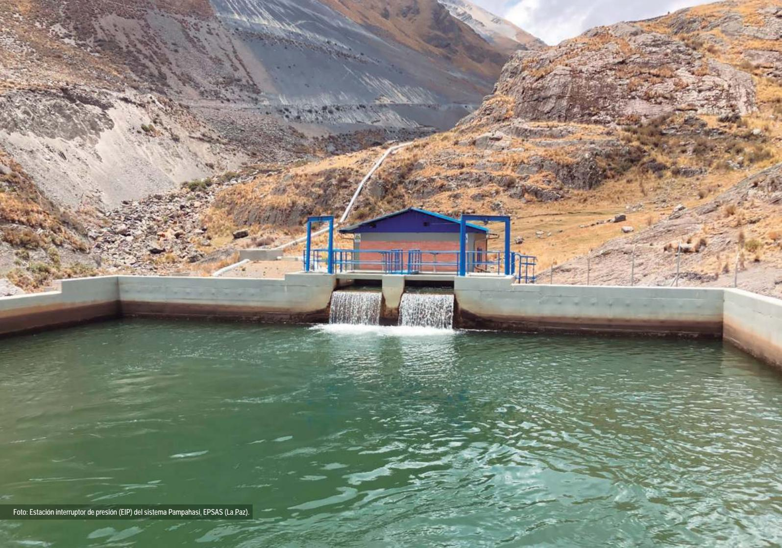
Foto: Estación interruptor de presión (EIP) del sistema Pampahasi, EPSAS (La Paz).
